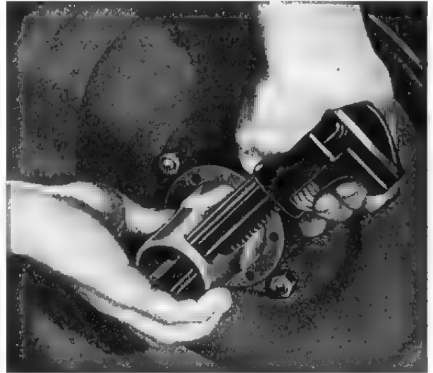
FIG. 4—REPLACING HUB NUT
